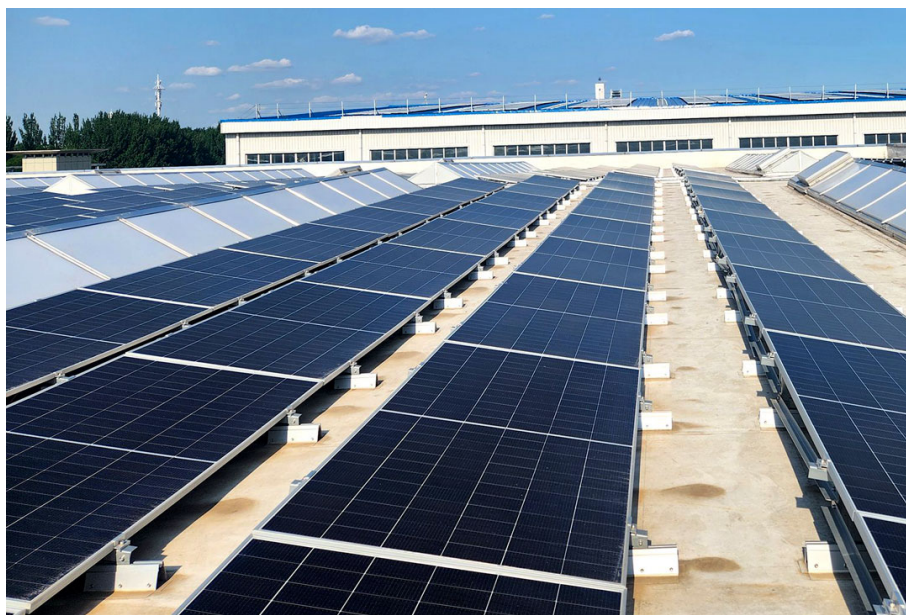
V-NP-S 南向傾斜取付——Boysen TPO プロジェクト実景
